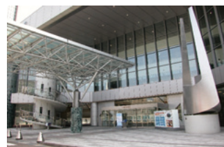
金沢駅側外観
